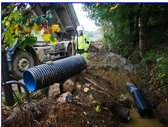
Travaux au terrain de tennis
