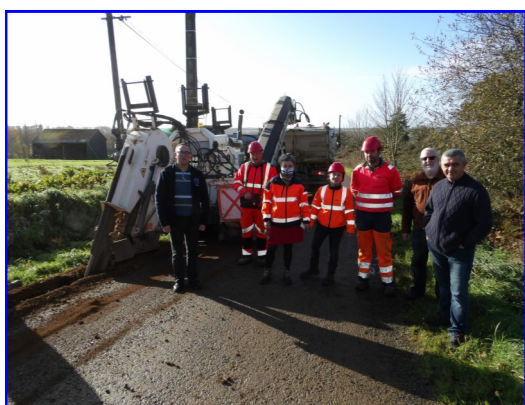
Réunion de chantier travaux d'enfouissement des réseaux / SDE
