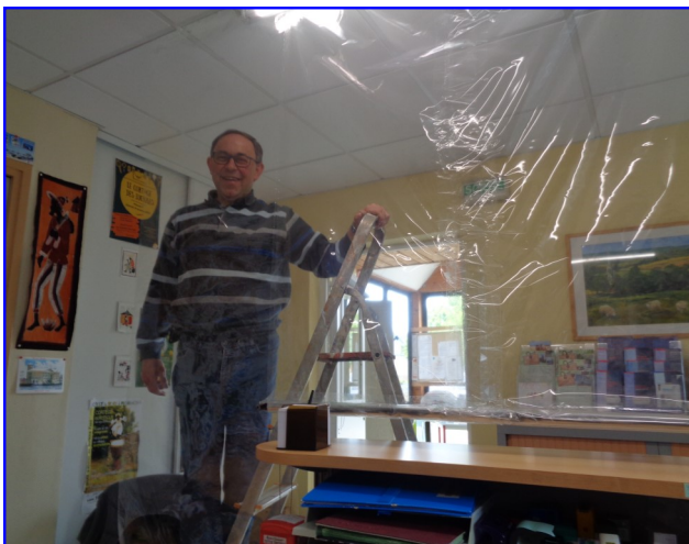
Installation d'un plastique pour pou- voir recevoir le public en mairie (Agent technique en arrêt de travail)
