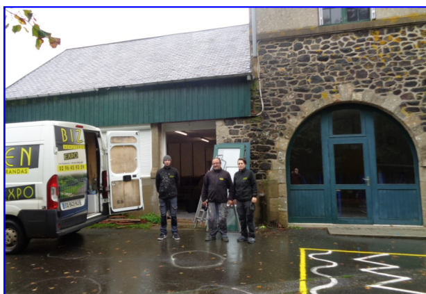
Remplacement des portes de l'école
